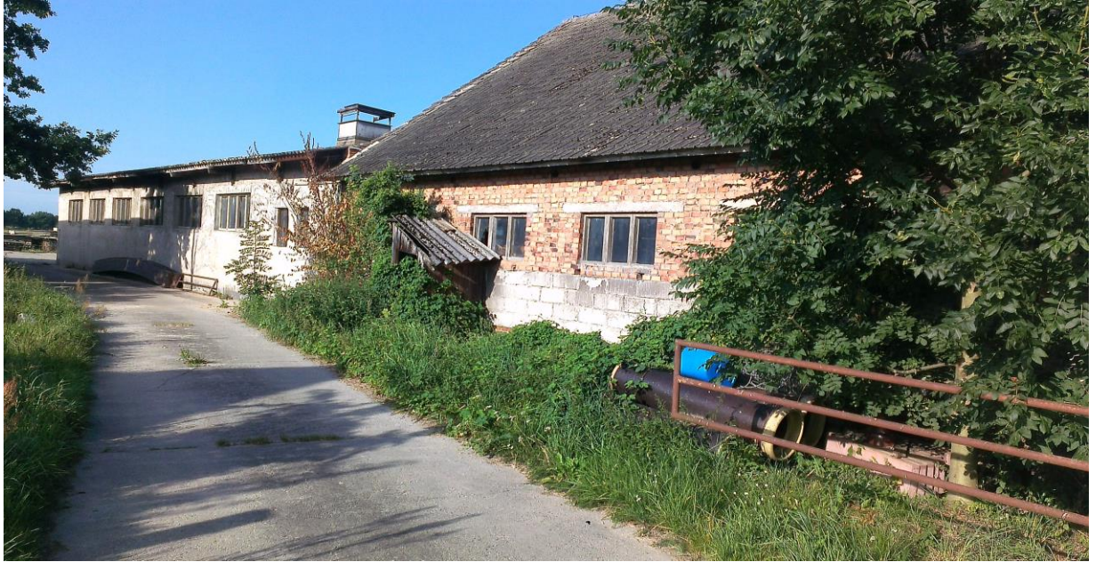
Ansicht der Stallanlage von Westen
