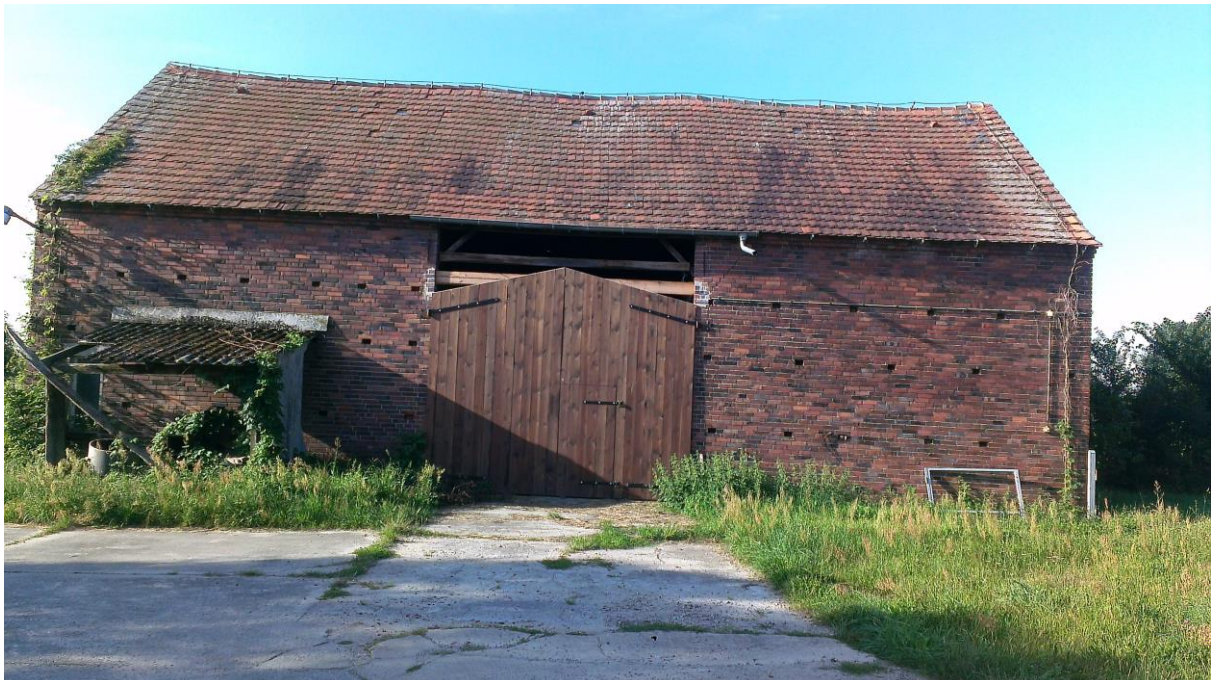
Ansicht der vorhandenen Scheune von der Hauptstraße
