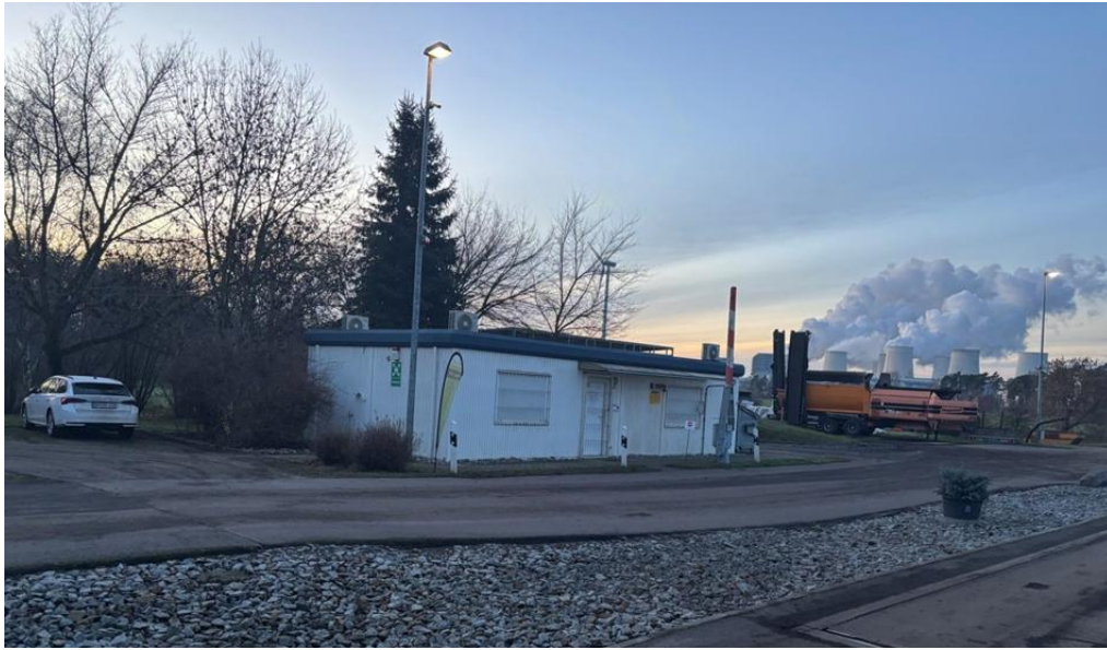
Bild 3: Bürocontainer, von Südosten aus (Toreinfahrt) fotografiert
