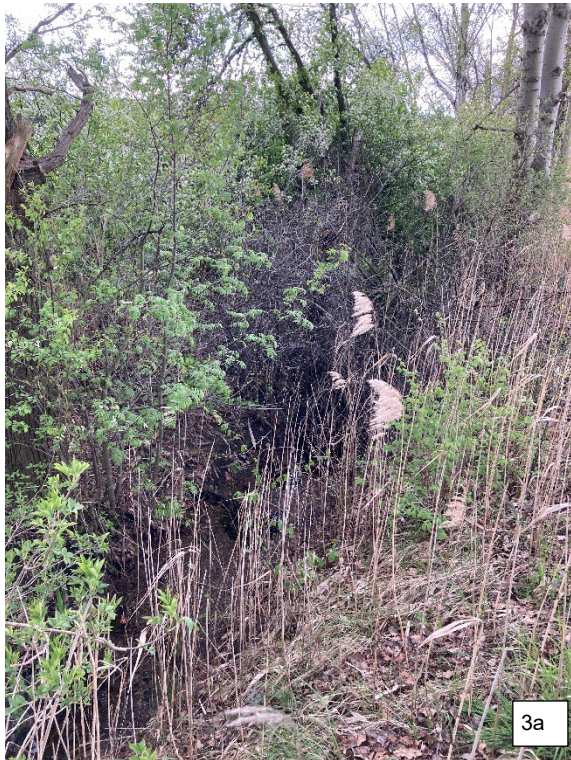
Abbildungen 3a-c: der „Bärenbrücker Hauptgraben“ am 26.04.2023
